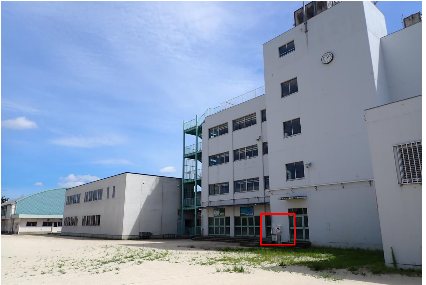
五本松小学校（設置場所：校舎校庭側の壁面）
