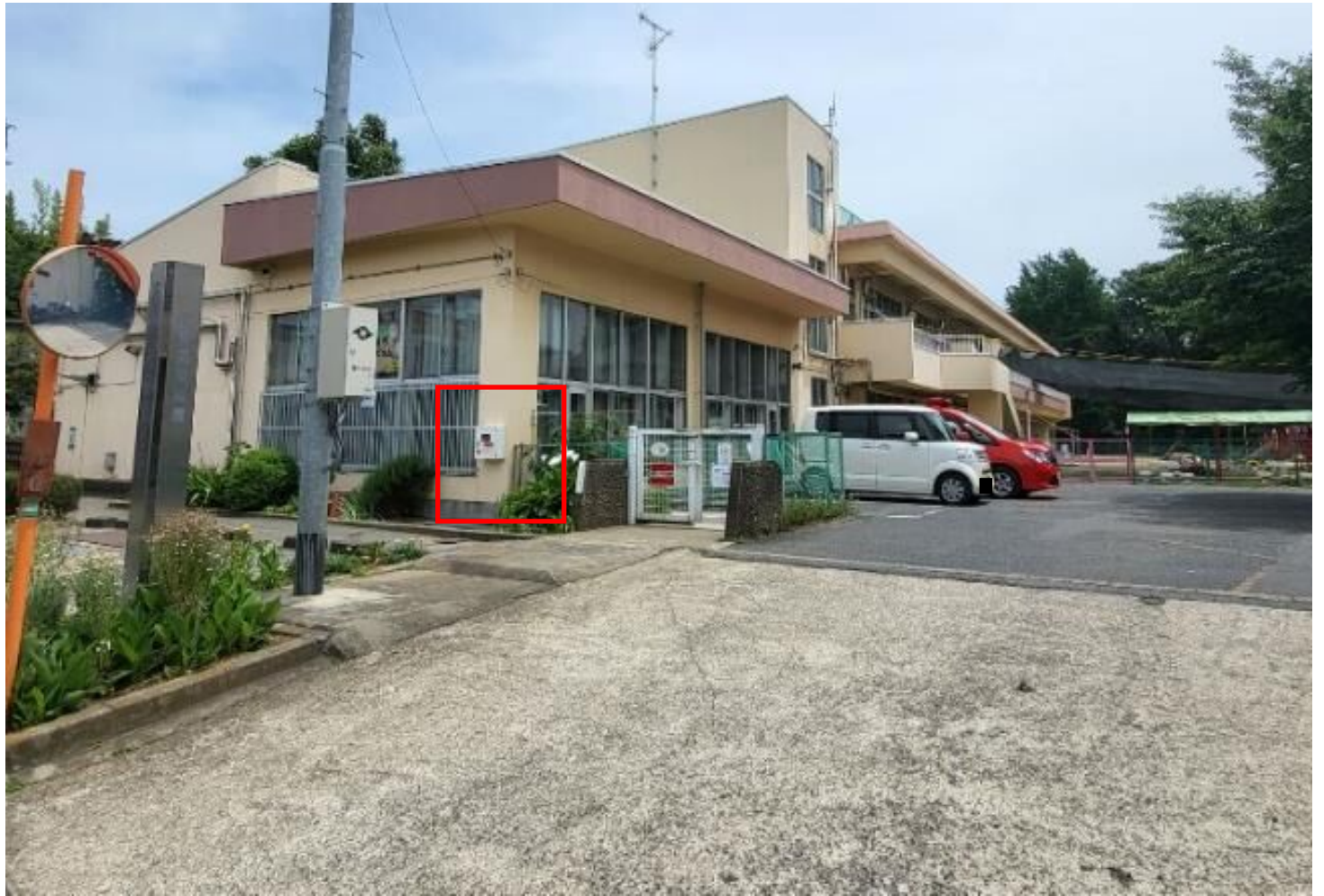
道野辺保育園（設置場所：施設壁面）
