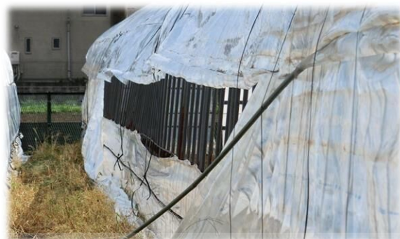
令和元年房総半島台風により被災したハウス
