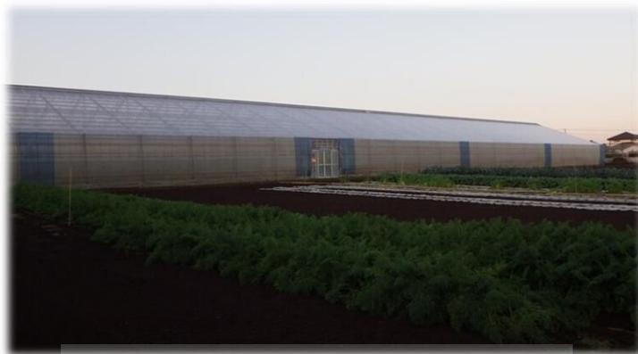
コンピューター制御を活用したビニールハウス
