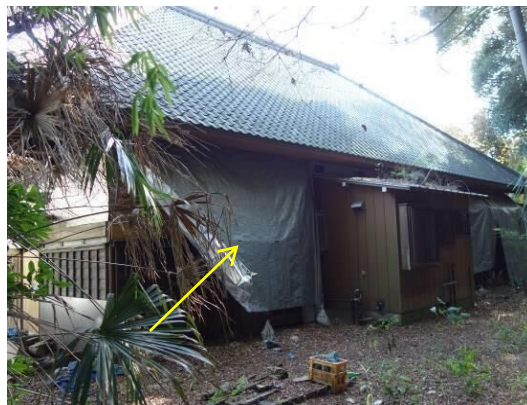
応急修理の状況（西面）
