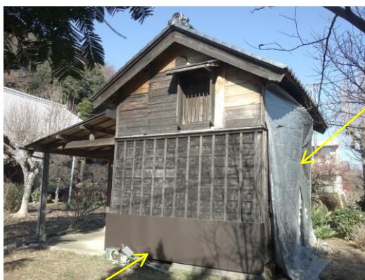
応急修理の状況（左：南東面、右：北西面）
