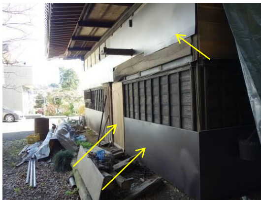
応急修理の状況（北面）
