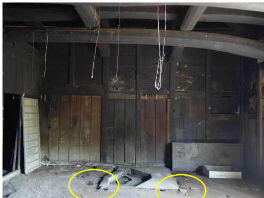
三和土 たつき に複数見られる穴（ドマ（手前）の北面）
