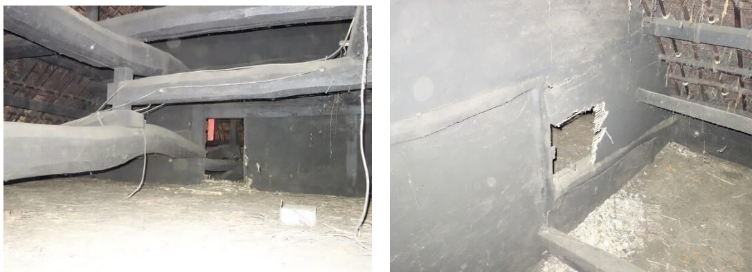
土壁に開けられた穴（左：ザシキとナカノマの部屋境 右：チャノマとヘヤの部屋境）
