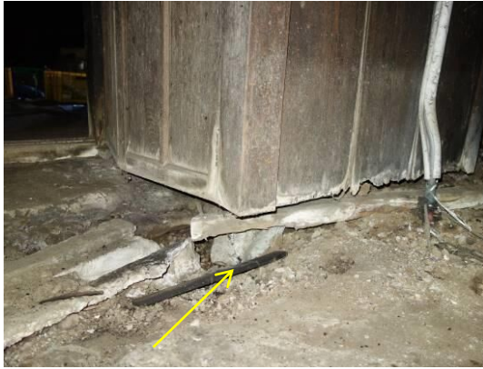
フロの欠失した基礎石（北西隅）
