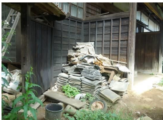
板壁に接して置かれた資材等
