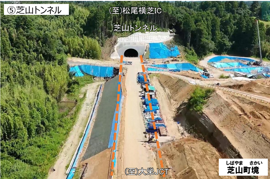
NEXCO東日本 千葉工事事務所より提供 R7. 7撮影
