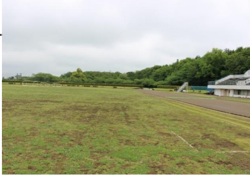
トラックの全天候とフィールドの人工芝化を行います (陸上競技場)
