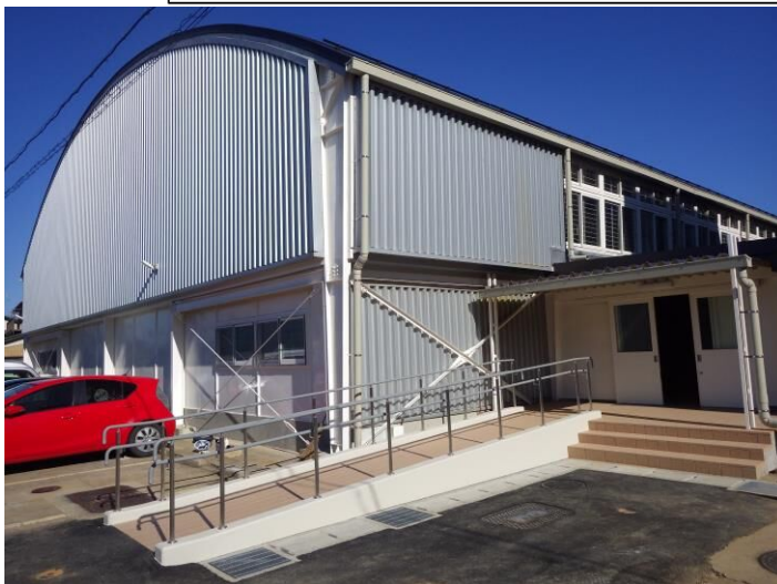
屋根も床もきれいに(南部小体育館改修工事)
