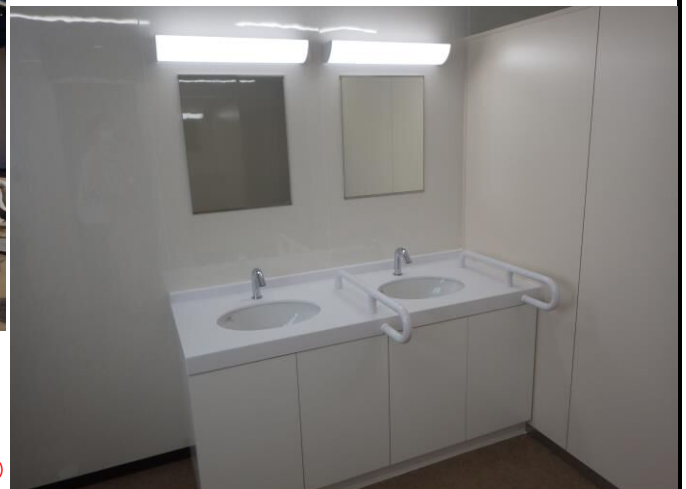
床の乾式化でより衛生的に(五中トイレ改修工事)
