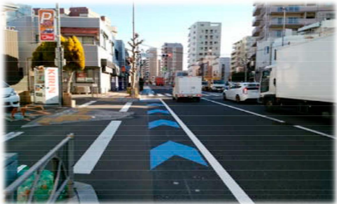
写真 3 - ① 車道混在の事例（歩道のある道路）
