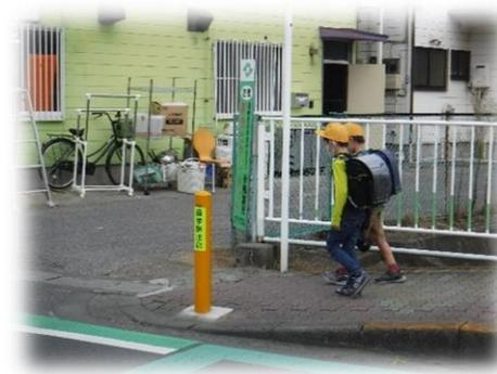
車止め（鋼製）（市道2339号線）
