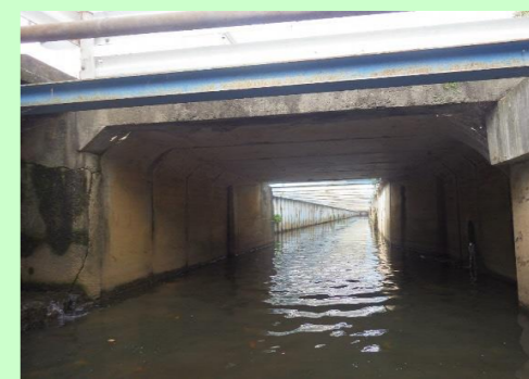
横上橋（橋長4.5m 47年経過）
