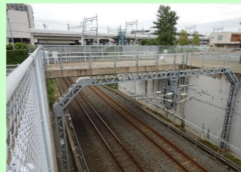
新鎌ヶ谷駅南口歩道橋（橋長14.95m 12年経過）
