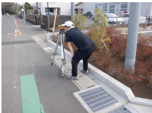
主に公共下水道工事の設計や発注、工事の監督業務を行っています。また、できあがった下水道に関する維持管理を日々行っています。下水道工事は既存の道路に管を埋設する工事が多く、工事を行うために道路の埋設管がどのように入っているか調査し、どこに下水道管を入れることができるのかを考えることから始まります。
