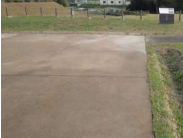
(道遺構表示：高炉スラグ舗装) (史跡柳之御所遺跡 岩手県平泉町)
