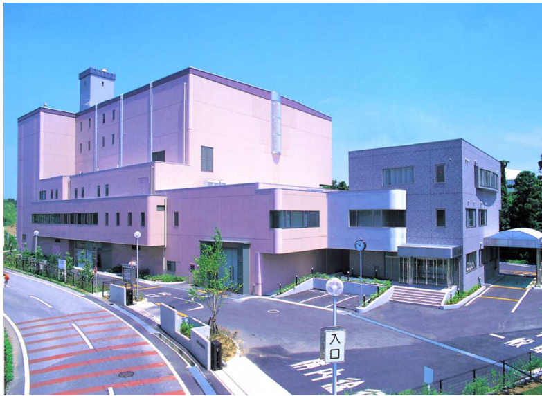
<写真>クリーンセンターしらさぎ
