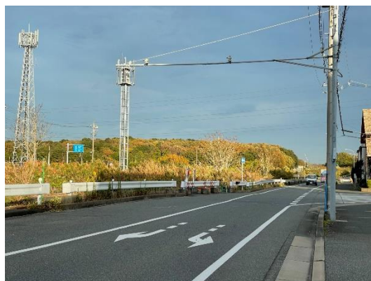
指定緊急輸送道路（国道 464 号）
