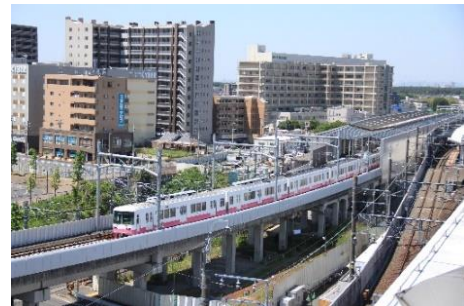
新京成線連続立体交差事業
