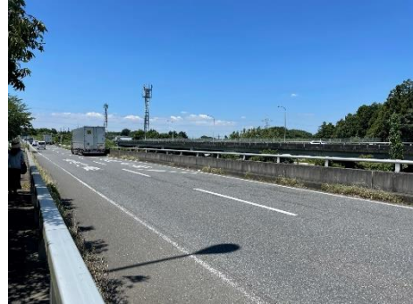
指定緊急輸送道路（国道 464 号）
