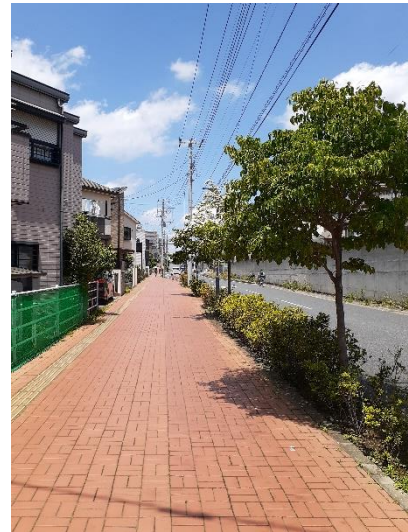
歩道の整備された道路
