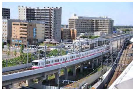
新京成線連続立体交差事業
