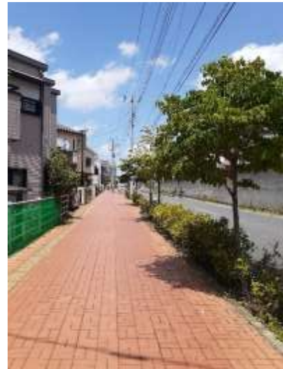
歩道の整備された道路
